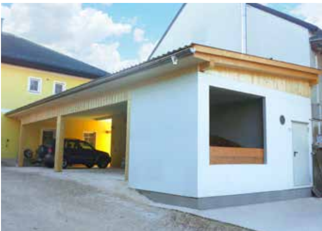
Enkelvoudige verwarmingscontainer bij woningbouw.
