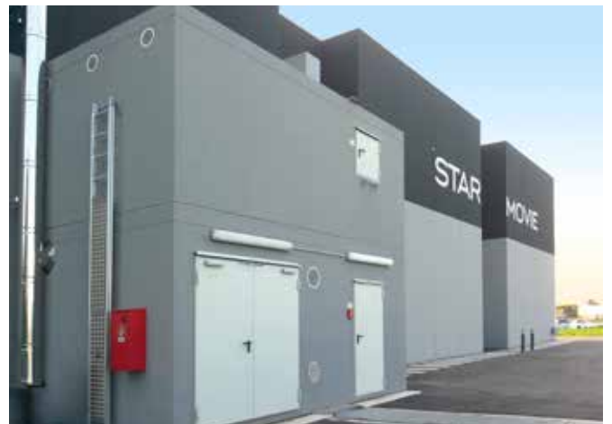
Tweeledige houtsnippercontainer naast een fabrieksgebouw.
